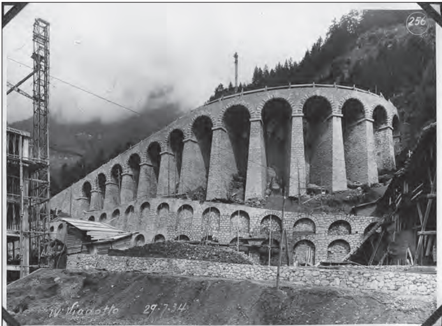
Villaggio sanatoriale di Sondalo, costruzione del quarto viadotto di fianco al terzo padiglione, 1934 (Archivio fotografico privato Giani-Castiglioni, Varese)
